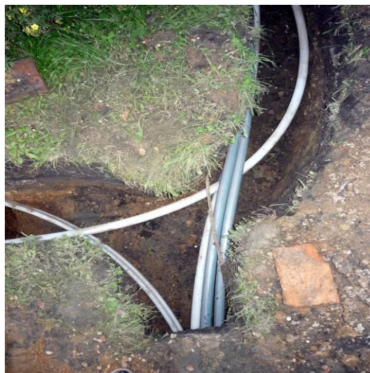
Obrázek 2 - trubky HDPE ve výkopu
